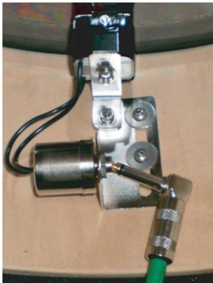
L字型ジョイントのピックアップ本体取付ネジ穴の長丸3mmを用いて、ヘッドの振幅幅とチューニングに合わせて、位置の微調整を行って下さい。ラグのネジに固定が完了してから、左の写真の様にシールド缶ジャックを逆側から取り付けます。
